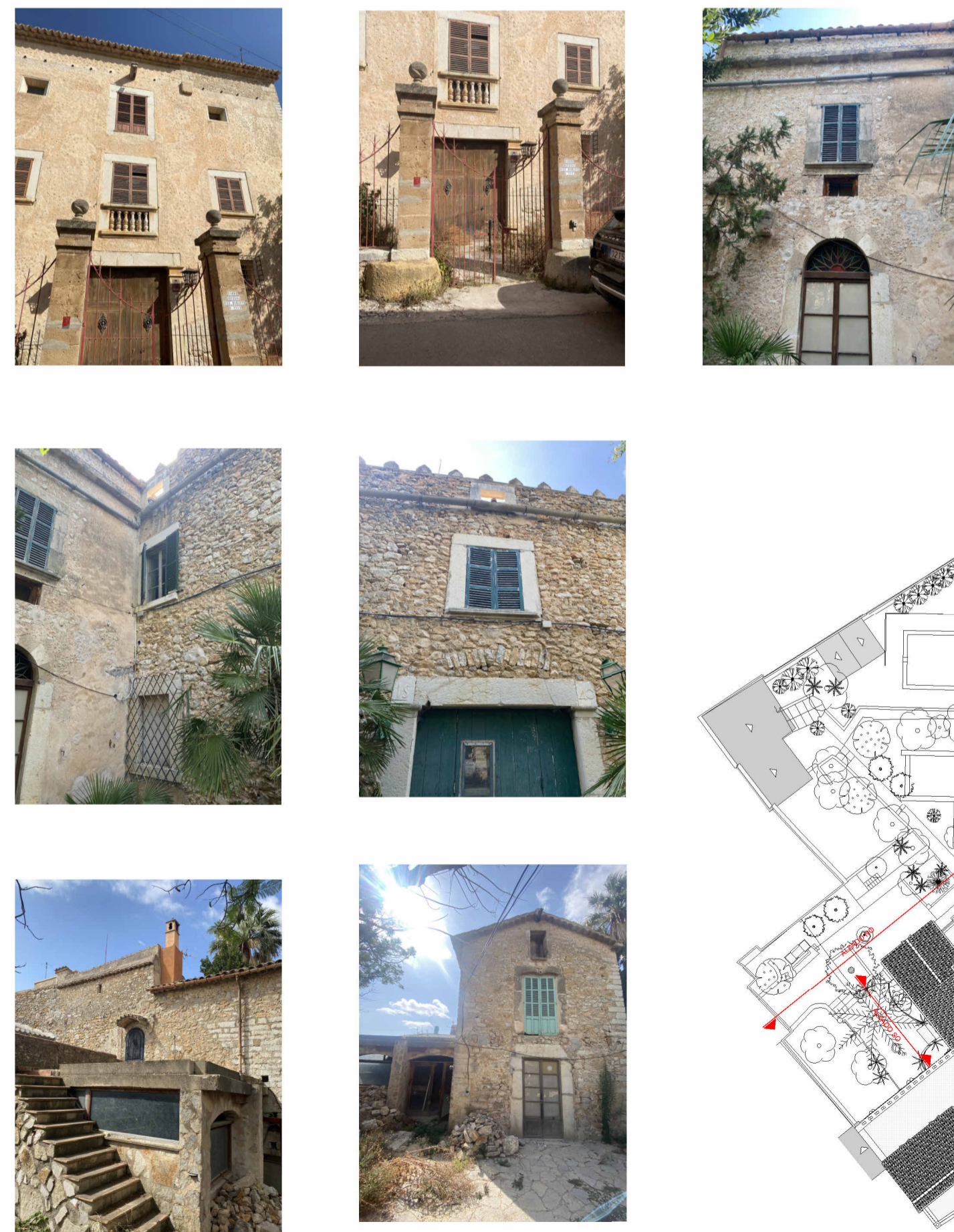
FOTOS ESTADO ACTUAL FACHADAS
